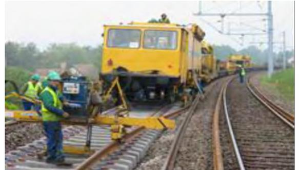
Longs Rails soudés sur traverses béton
