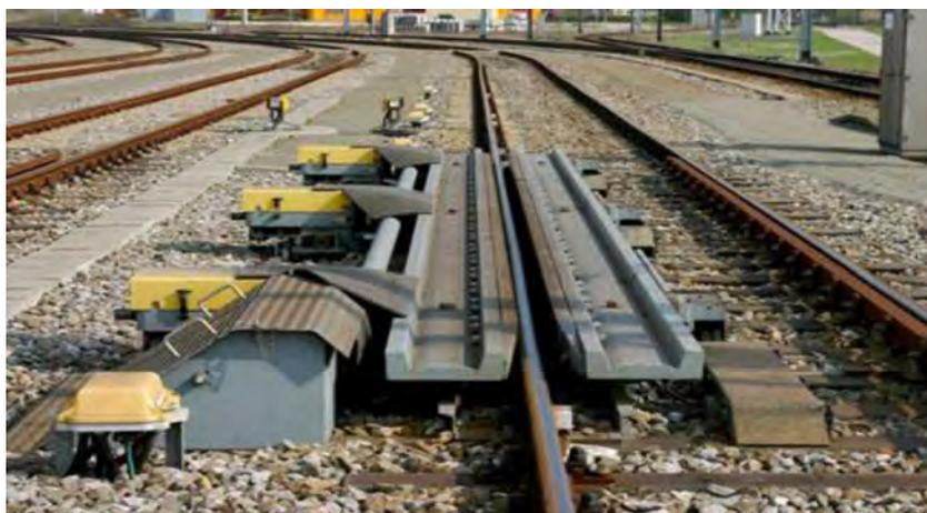
SNCF-Réseau a également mis au point une solution d'écran bas d'une hauteur inférieure à 1,00 m, placé très près du rail. Cette solution non encore homologuée en France montre son intérêt lorsqu'elle est combinée à un carénage du bas de caisse des trains, mais ne permet pas de réaliser pour le moment certaines actions de maintenance des voies.
